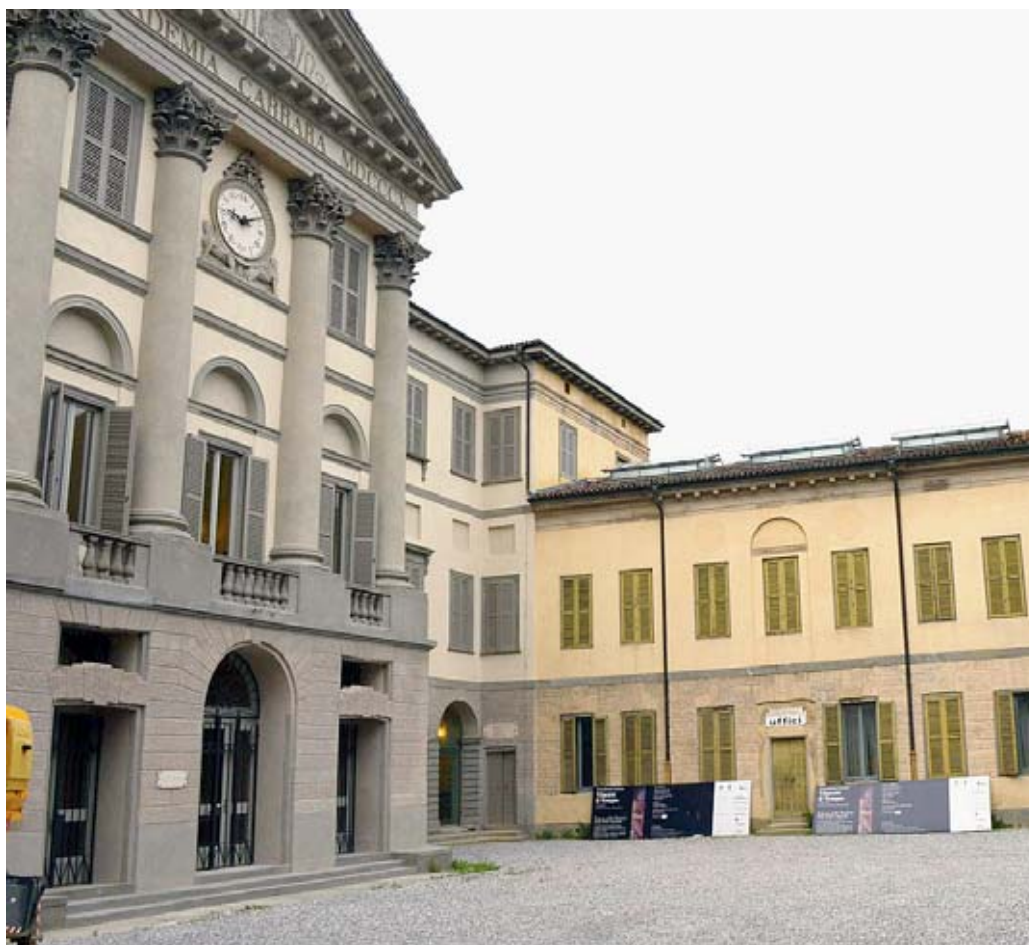
La facciata appena restaurata dell'Accademia Carrara
